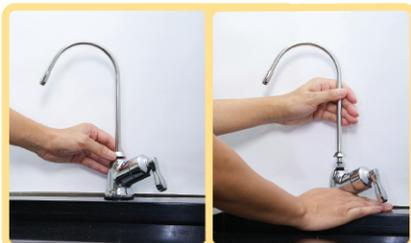
▲一手握住鵝頸水龍頭主體，另一手以逆時針方向旋開噴嘴下方的固定螺帽，將噴嘴自底座中拔起。
